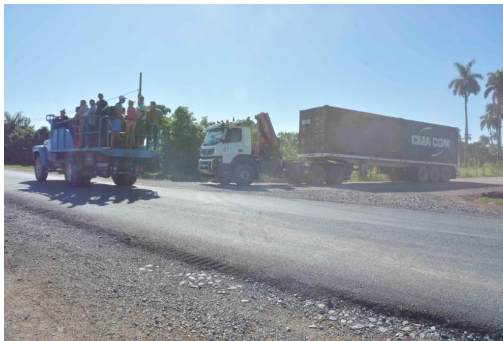
Los dos primeros kilómetros de los 23 previstos ya fueron concluidos
