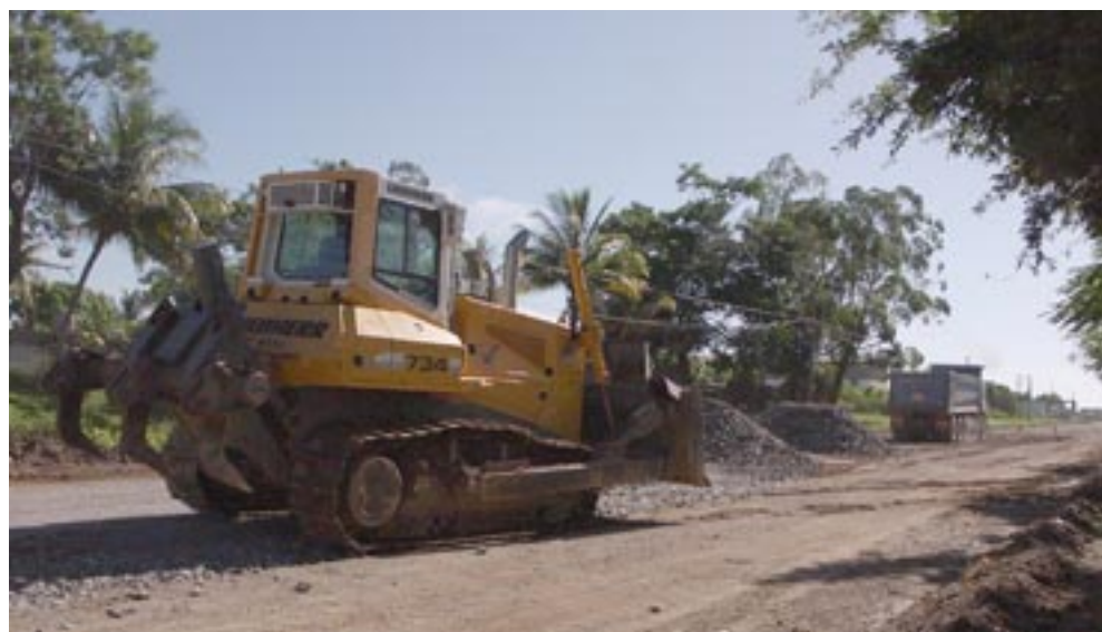
Emincar facilita los equipos para el movimiento de tierra que precede a la pavimentación
