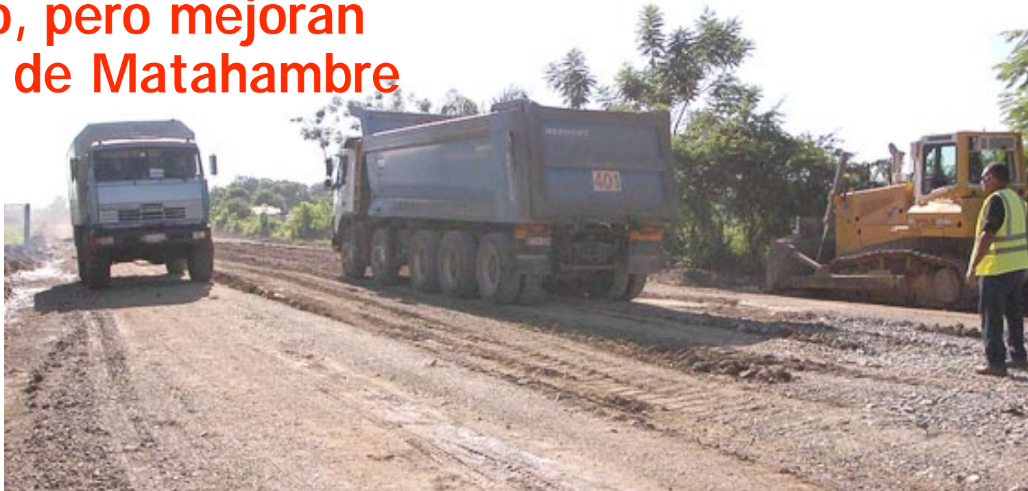
El tránsito vehicular por las vías donde trabajan no se detiene
