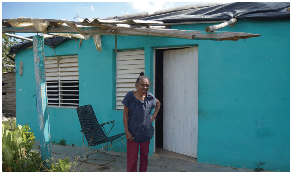
En la zona de Forteza, viviendas como la de Eleodora, aún permanecen con lonas de polietileno como techo
