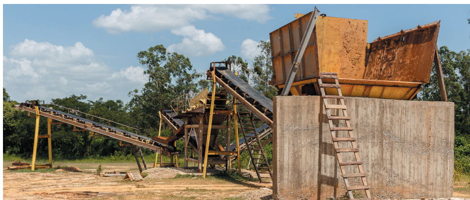
La producción de elementos de pared se ha visto perjudicada por el déficit de cemento
