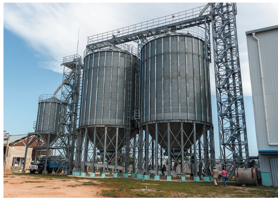
La expectativa con el emplazamiento es que se puedan cerrar ciclos productivos una vez que se concluya todo el complejo
