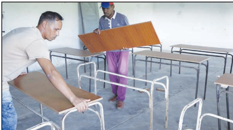
La reparación del mobiliario de las aulas recientemente recuperadas es la prioridad para el colectivo de trabajadores de la ESBU José Martí
